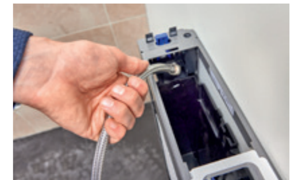
↑ Le tuyau flexible tressé et renforcé pour le raccordement de l'arrivée d'eau peut être posé sans avoir à déplacer le réservoir, ce qui facilite la tâche de l'installateur.
