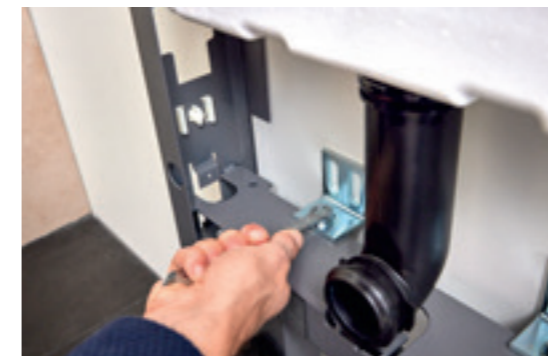
↑ Des équerres de montage testées et éprouvées sont utilisées pour fixer le cadre au mur.
